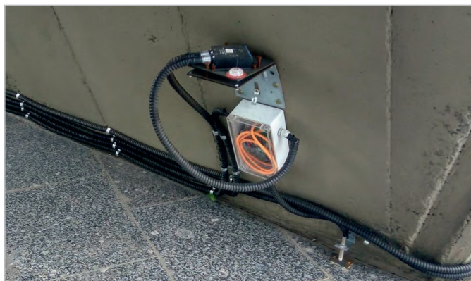
Рис. 13. Иллюстрации возможного крепления датчиков детонации и деформации
