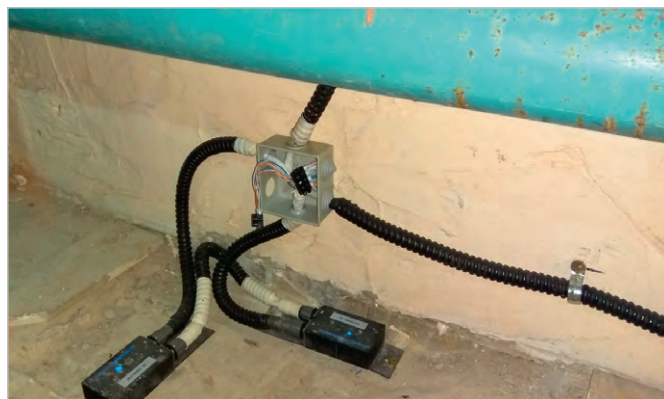
Рис. 14. Иллюстрации возможного крепления датчиков детонации и деформации
